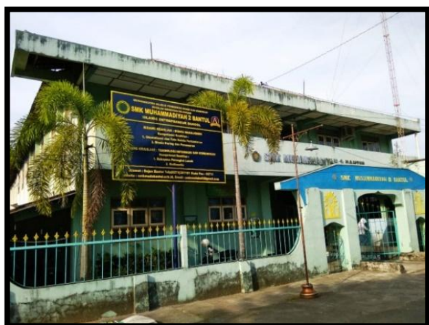
Gambar 1.1. Gedung SMK Muhammadiyah 2 Bantul
