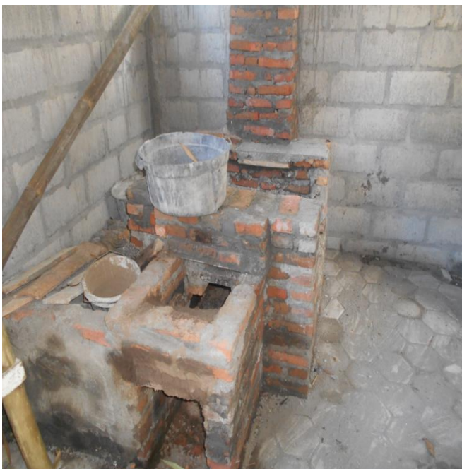
Gambar 5. Perbaikan tungku memasak nata
